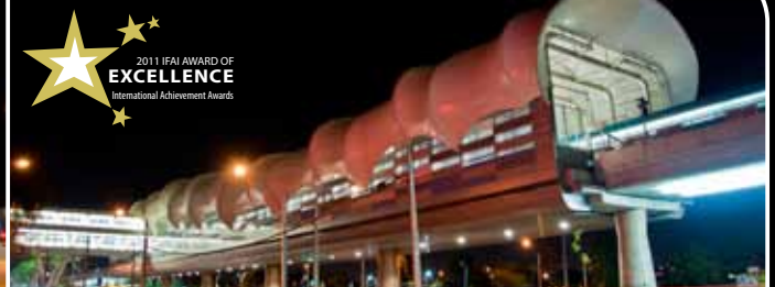
Estación de metro Laguna Sur
